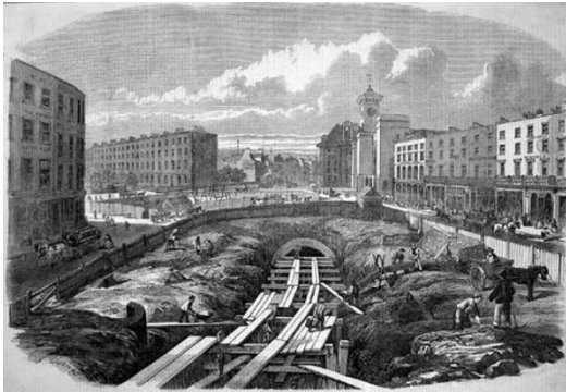
Будівництво метрополітену в Лондоні
